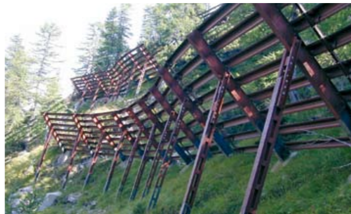
Kirchlespitz, Malbun: Lawinverbauungen verhindern das Anreissen von Lawinen und ermöglichen bei guten Bedingungen das Aufkommen von Wald.
