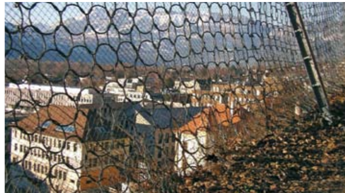
Schlosshalda, Vaduz: Steinschlagnetze übernehmen die fehlende oder ungenügende Schutzleistung des Waldes.
